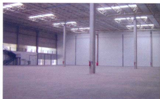
A característica térrea (ou no máximo de dois pavimentos) dos galpões logísticos, atrelada ao uso de pré-moldados, faz da construção uma atividade de baixo risco
